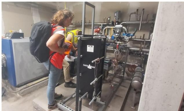
Une des deux chaudières gaz du Collège est conservée (300KW) : la sous station installée à la place de la seconde permet de prendre le relai sur le système Bois en cas de besoin.
